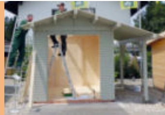
Erstellung der Dachschalung
