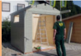
Einsetzen der fertig montierten Wand- und Giebelelemente
